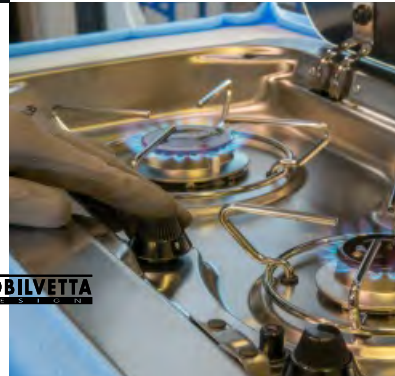
Überprüfung des Betriebs und der korrekten Installation der elektrischen Systeme
