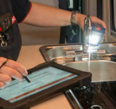
Abnahme Gasanlagen durch Fachpersonal.
